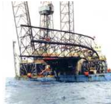
그림 1. 설치시스템 파괴
